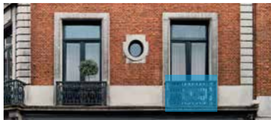
Низкая высота делает блок невидимым изнутри и незаметным снаружи
